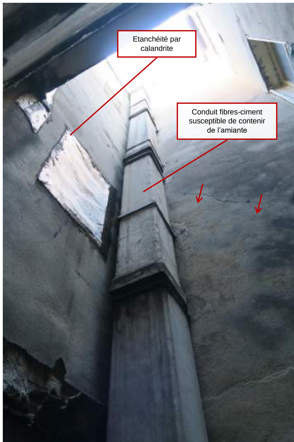
Vue cour intérieure depuis sanitaire R+1
