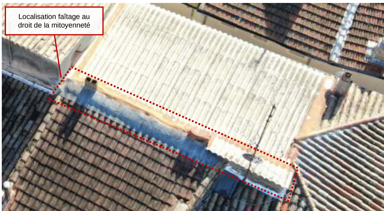
Vues pan Sud de couverture
