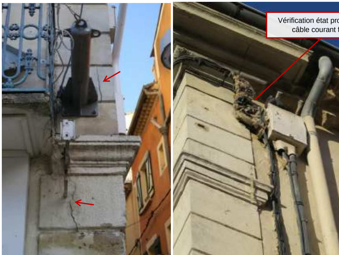
Vue façade depuis rue Saint-Martin
