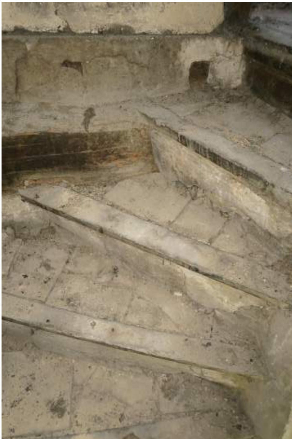
Vue escalier accès R+3
