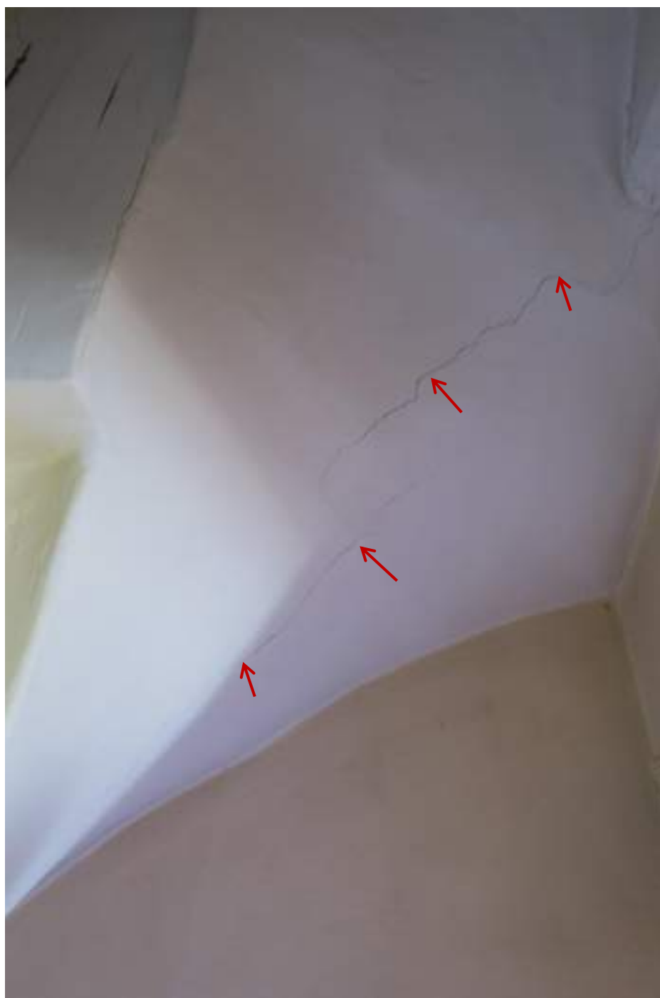
Vue sous-face paillasse volée d'escalier accès R+2
