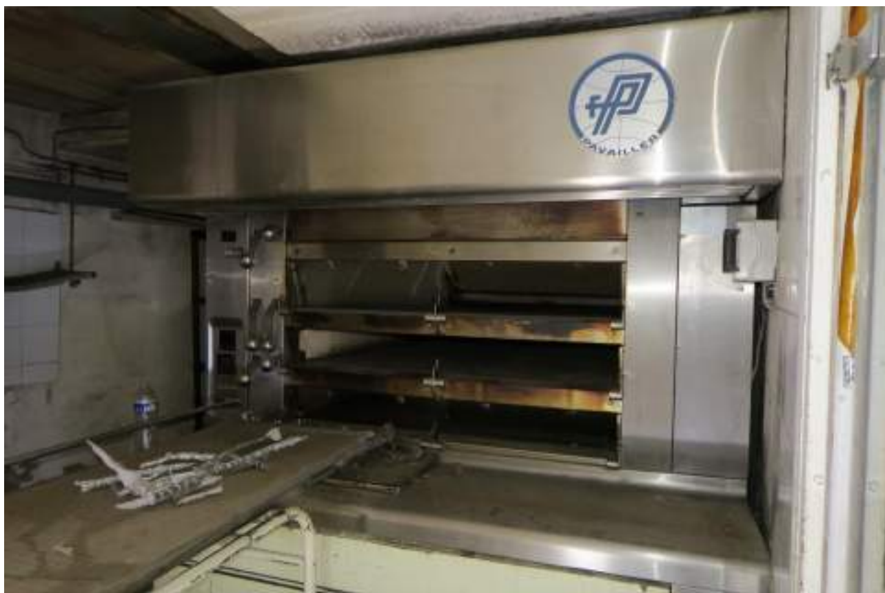
Vues locaux RDC four boulangerie
