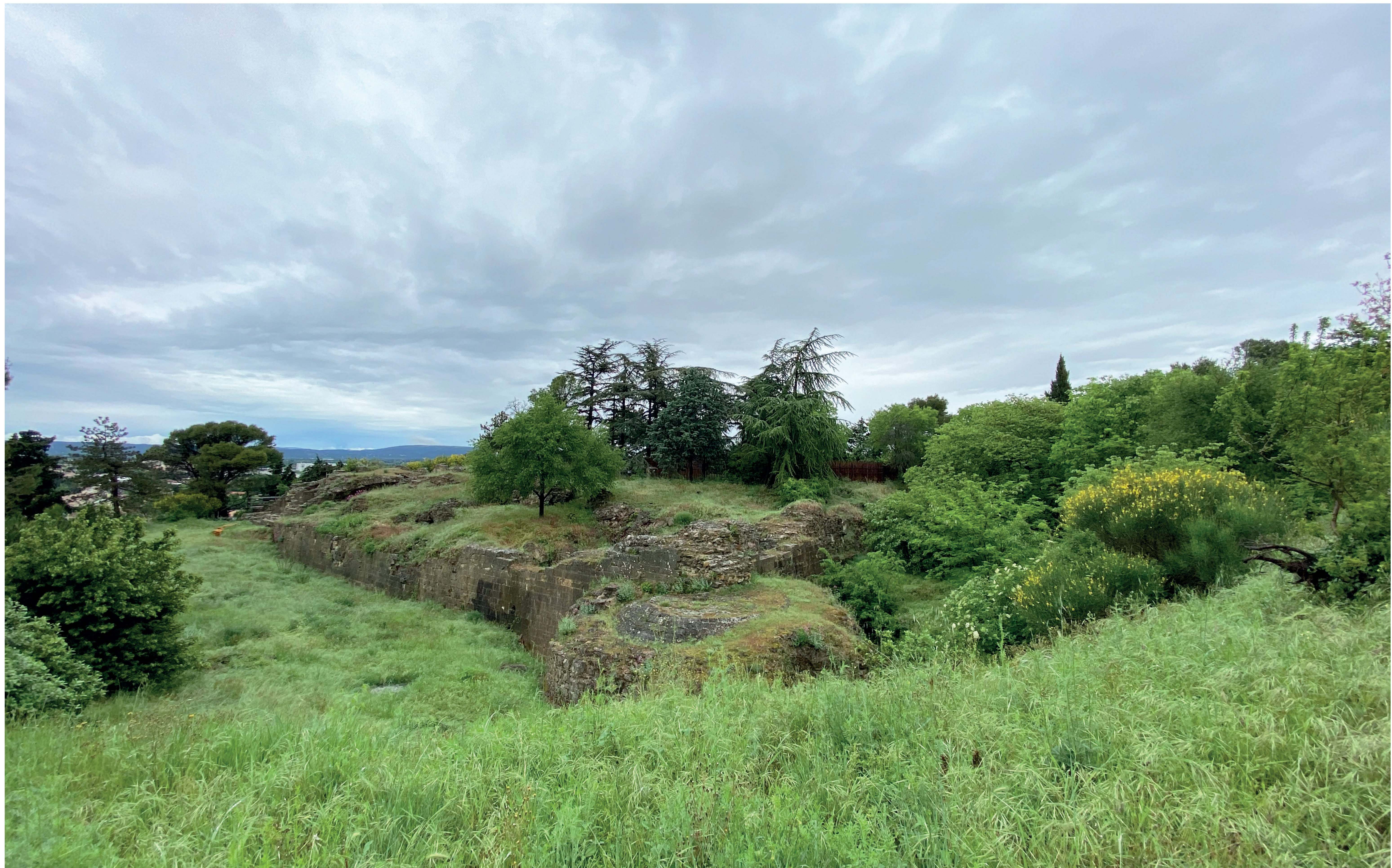
Vue depuis le sud-est du château avant intervention
