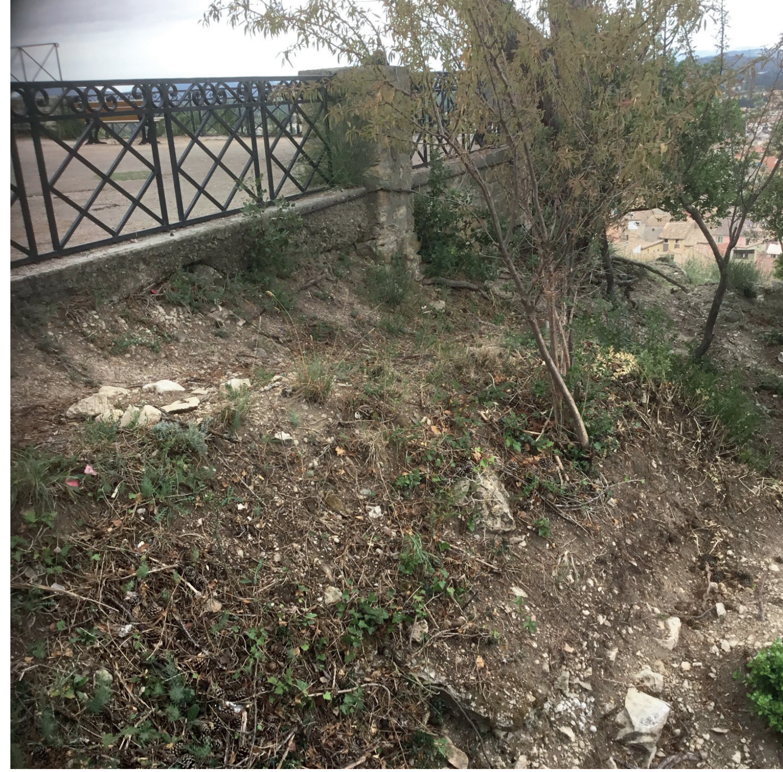
Courtine est avant intervention
