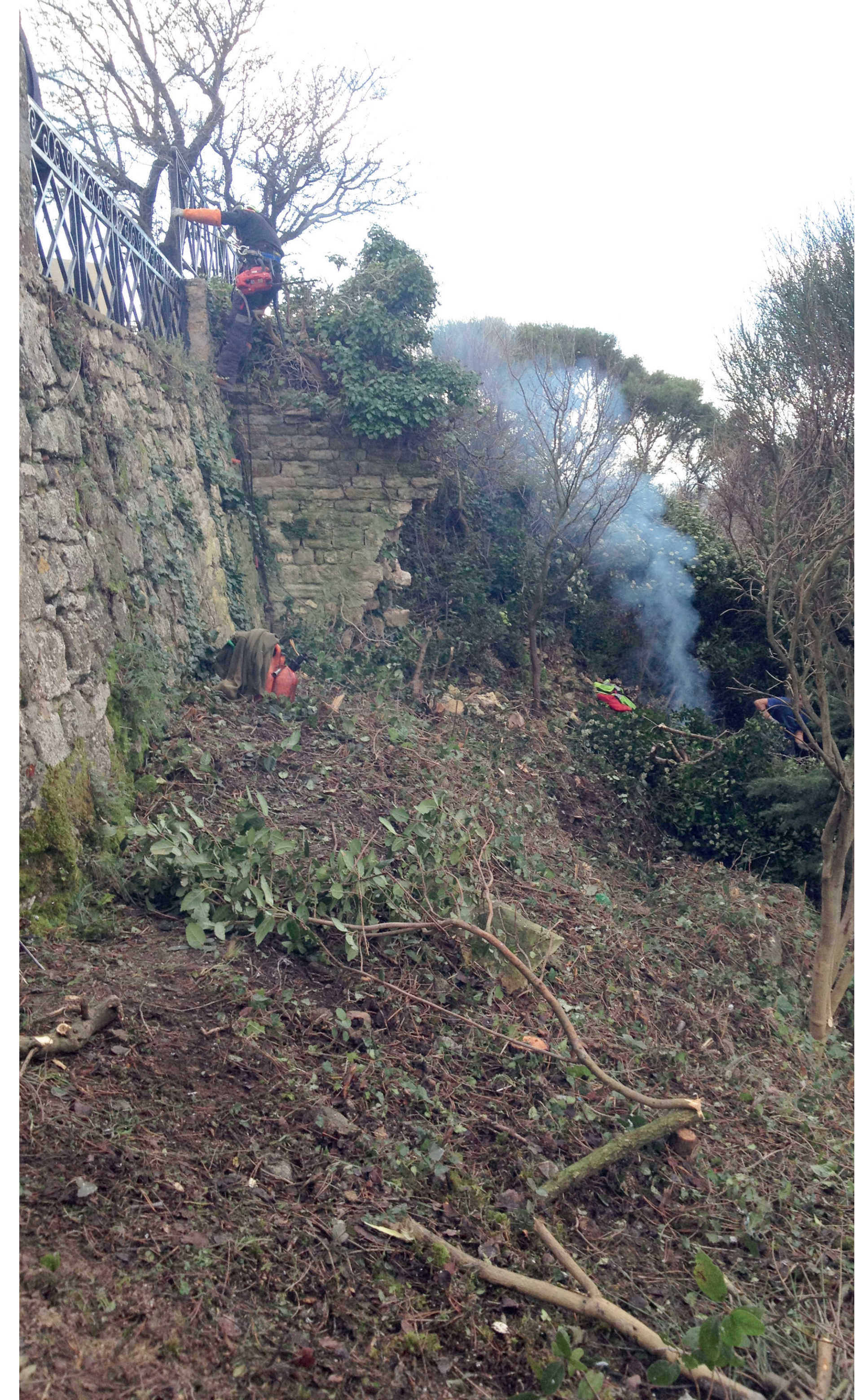
Courtine nord avant intervention (débossage en 2016)
