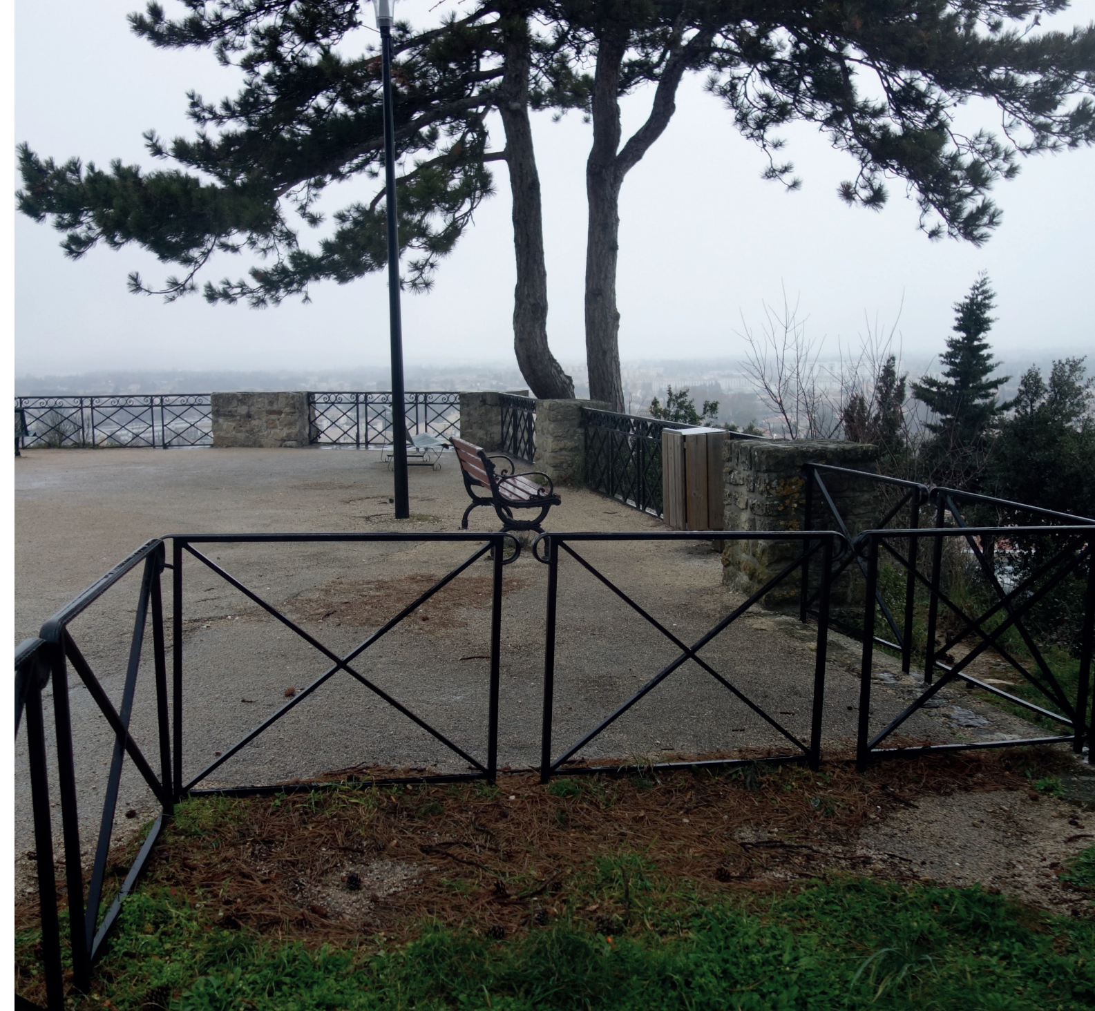
Terrasse du château avant intervention
