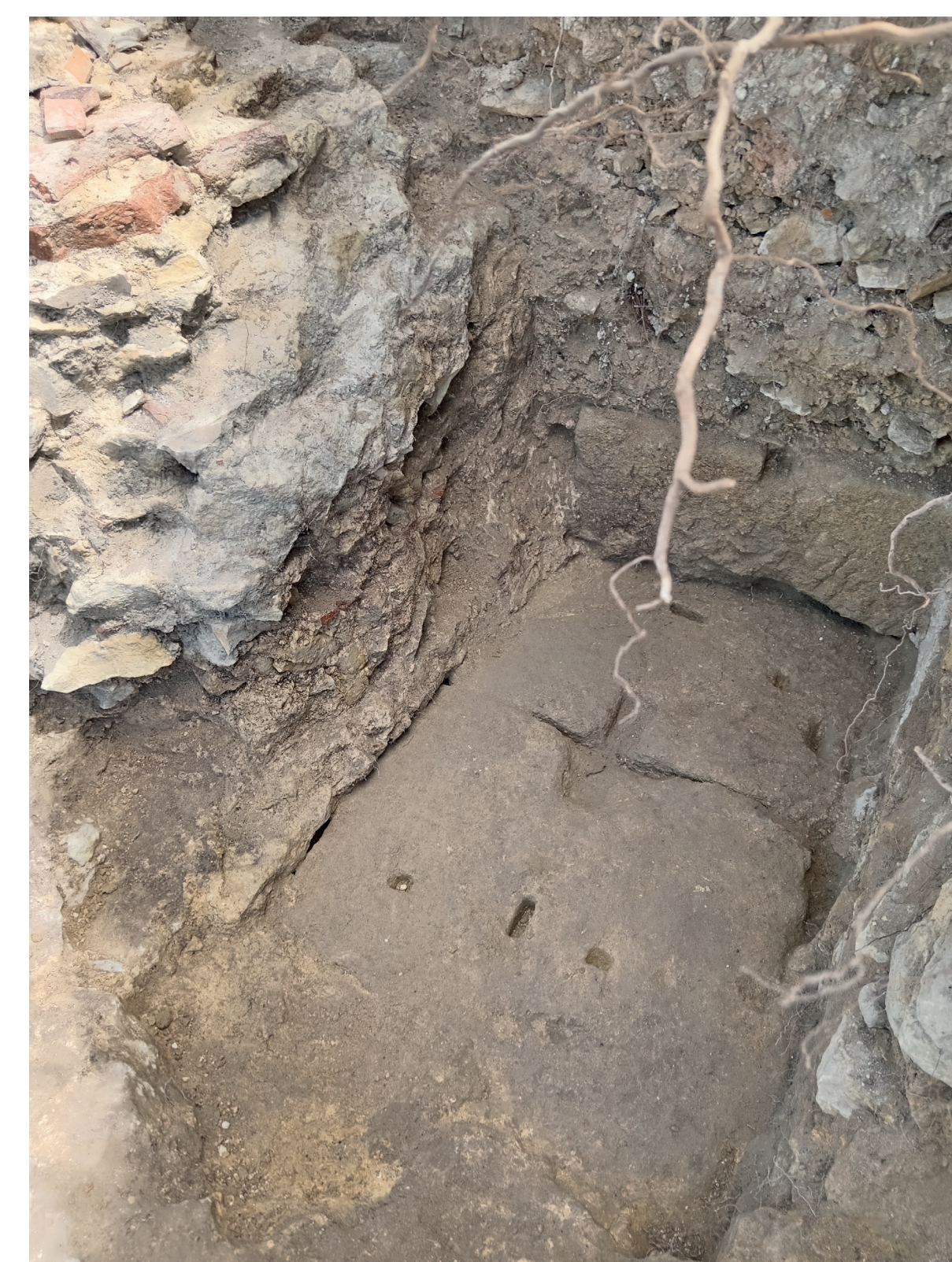
Vestige d'un édifice antique inconnu sur la courtine nord
