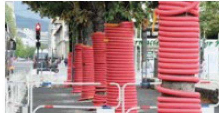
Fig. 25 : Gaines TPC rouge éléments de protection et de signalement des troncs
