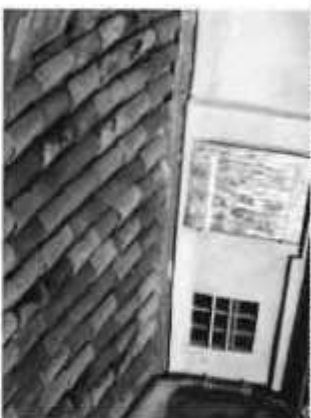
Croquis de solin au mortier et exemple de solin plomb
