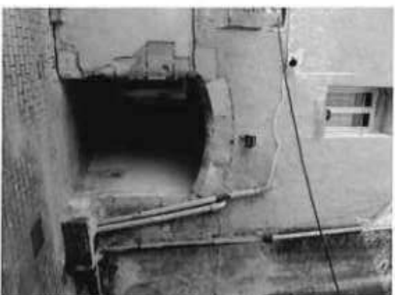
➤ Débouché du passage couvert sur la cour. Encadrement en pierre de taille avec arc surbaissé.
