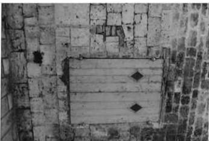
➤ Fenêtre avec linteau bois et trace d'un ancien percement cintre.
