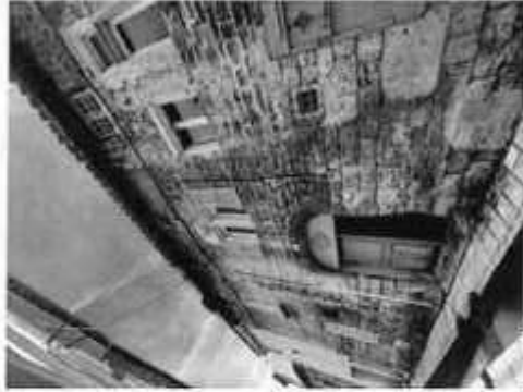
Rue Plaisance, quartier de Langes
