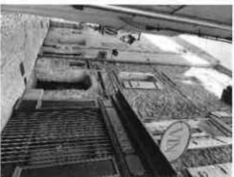
Enduit en sautoir par rapport à la pierre vue, disposition disgracieuse (chaîne d'angle par ex.)
