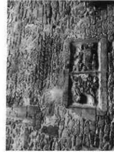
Baies à meneaux bouchées (horizontales) Appareil en épis (opus secundum)
