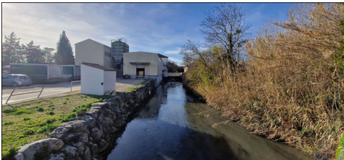
Vue sur les bâtiments au nord depuis le chemin des Négades et le pont enjambant le canal
