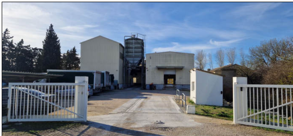
Vue sur les bâtiments au nord depuis le chemin des Négades
