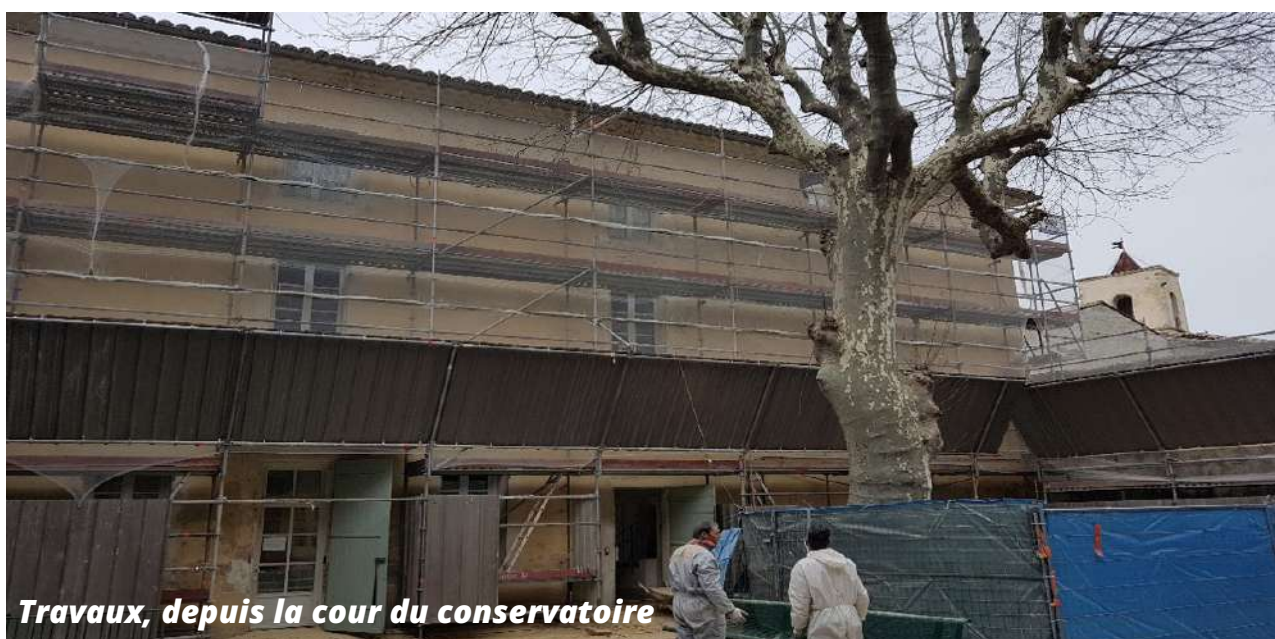
Avant travaux façade, depuis la rue de l'ancien collège
